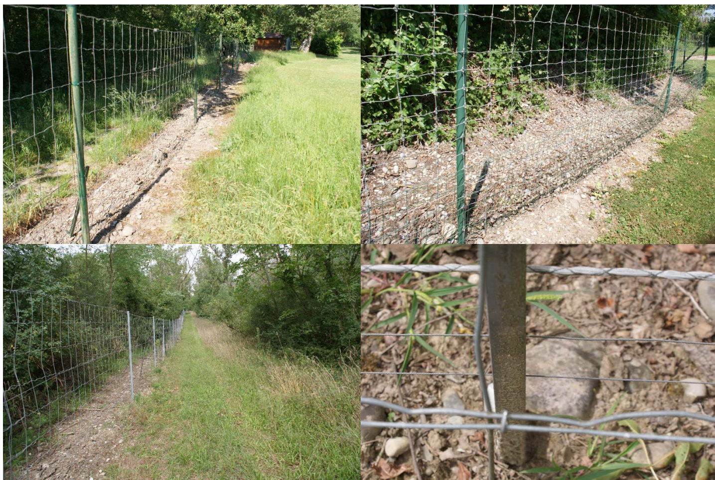
Aspect de la clôture électrifiée et du double maillage pour la petite faune. J. Boursier, Golf du Rhin, 2023.
